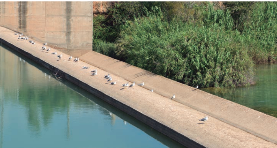
Gaviotas posadas en la presa del Pantanet de Santa Quitèria.
