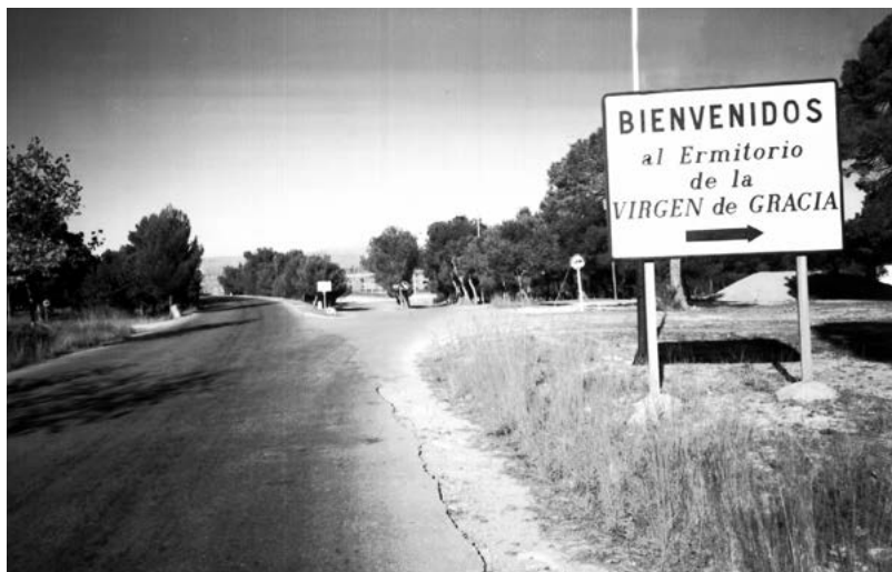
Carretera de la Ermita, entrada principal para vehículos al Termet (1960).
