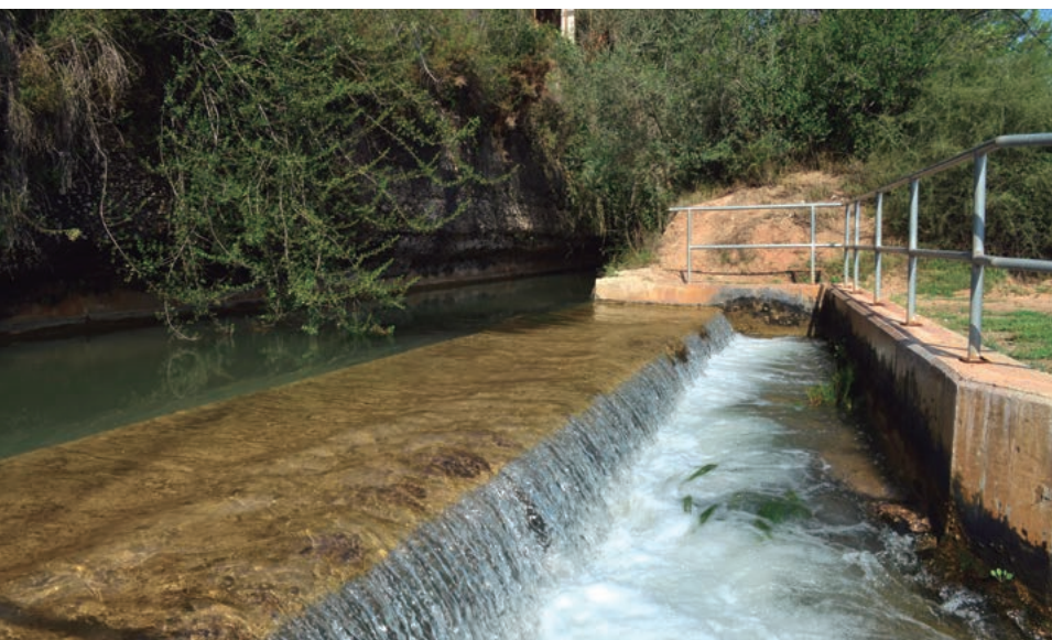
Regulador de las aguas de riego de la acequia Mayor y paso de los excedentes acuíferos de nuevo al río
